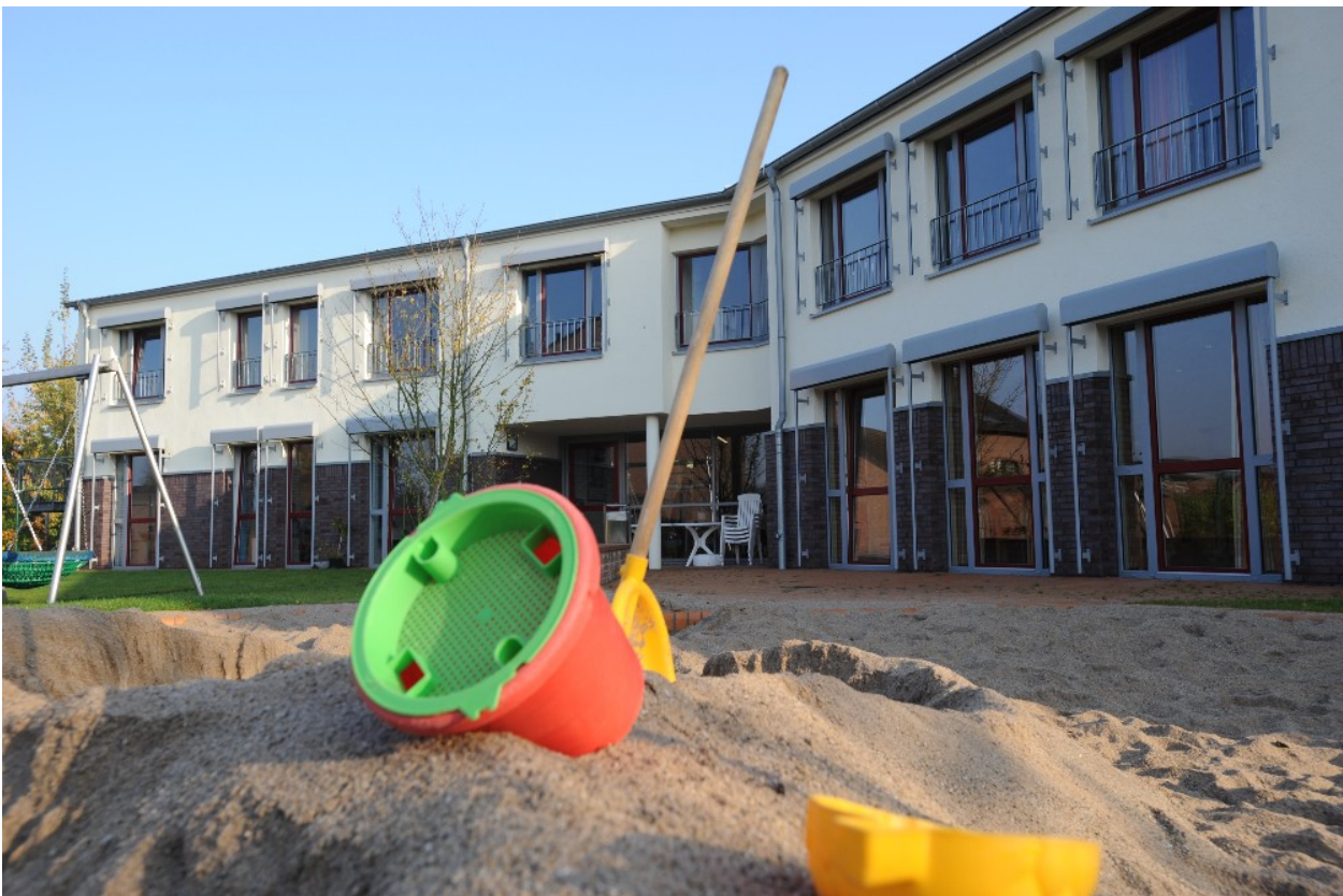
Gebäude der Tagesklinik für Kinder und Jugendliche in Mönchengladbach (Rückansicht)
